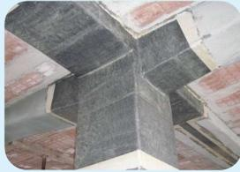
renforcement avec fibres de carbone
