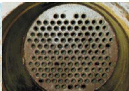
Esempio pratico: condizioni di 2 scambiatori di calore operanti in parallelo per due anni senza interventi di pulizia
